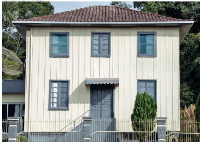
Antigos casarões guardam marcas da colonização italiana
