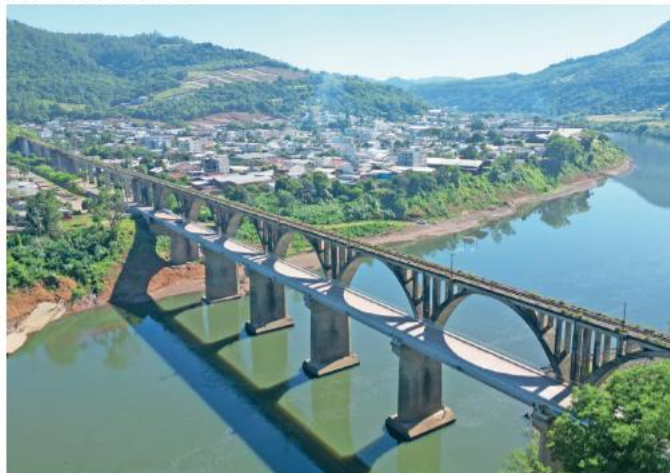
Ponte rodoferroviária Brochado da Rocha foi construída sobre o Rio Taquari
