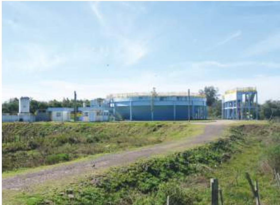
ESTAÇÃO DE TRATAMENTO DE ESGOTO ESTÁ LOCALIZADA NO BAIRRO MORSCH
