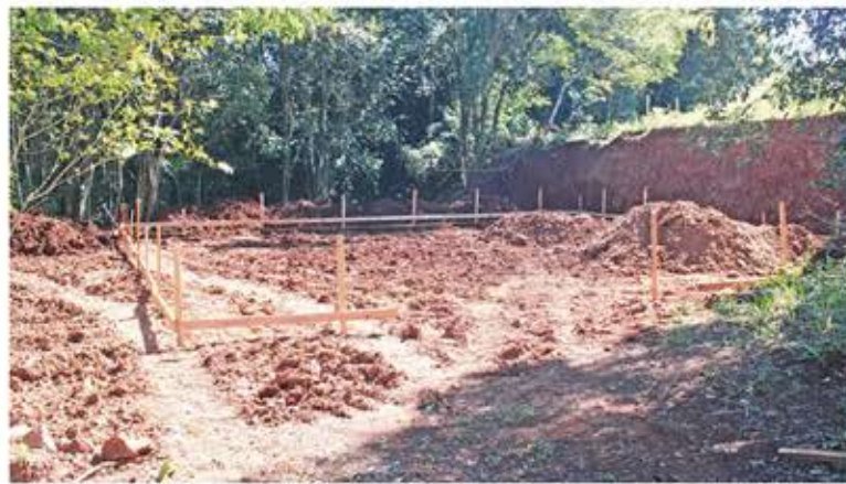
Área que receberá o Espaço Cultural foi preparada para receber as fundações
