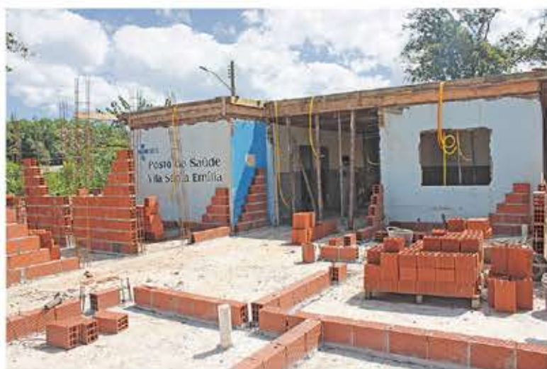
Obras na UBS Santa Emília tiveram atraso em função da chuva registrada nos últimos meses
